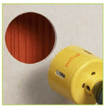
Boîte Ø 67 mm pour un meilleur espace de câblage (scie cloche Ø 67 mm)
