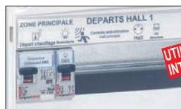
Exemple d'un coffret équipé d'une étiquette 387 20 avec porte-repère 203 99 et d'étiquettes pour Lexic 387 31/32
